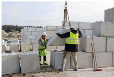
**BETONBLOXX®** bilden ein modulares Wandsystem, das in kürzester Zeit aufgestellt und auch wieder abgebaut werden kann (Verlegeanleitung kann beigelegt werden).
